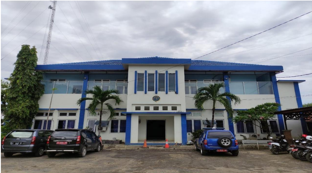
Gambar 2. 1 Gedung Kantor Dinas Perhubungan Kabupaten Pemalang
