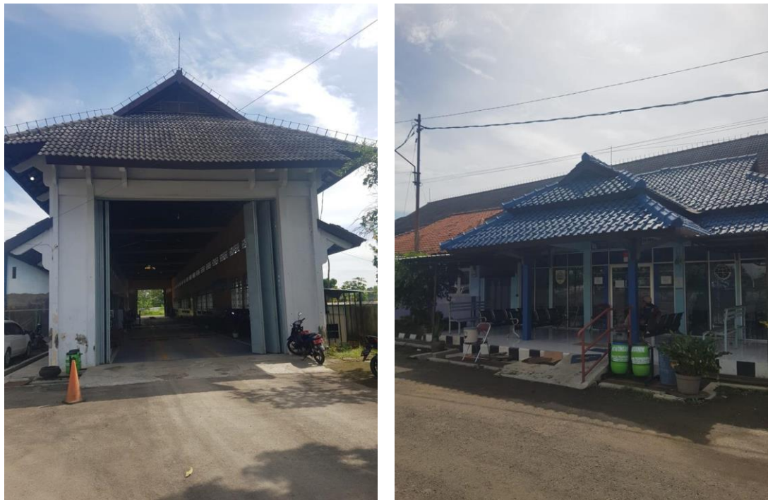
Gambar 2. 2 Gedung Unit Pengujian Kendaraan Bermotor
